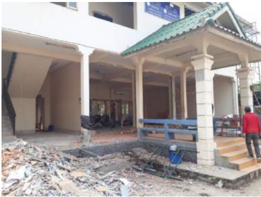
1階の壁を撤去
