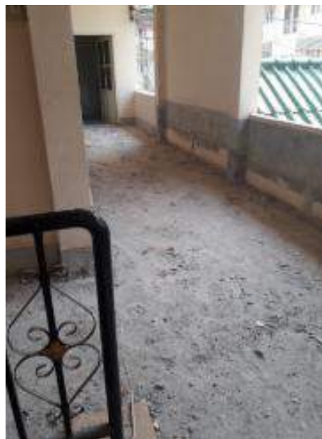
2階廊下のタイル剥がし
