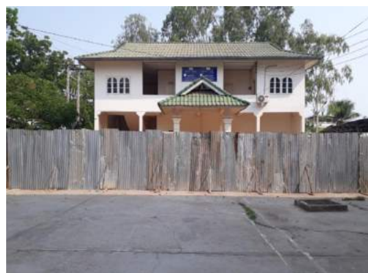
安全のため周囲に塀を設置
